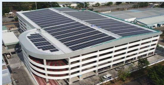
รูปที่ 5 การติดตั้ง Solar rooftop ในรูปแบบ Private PPA
