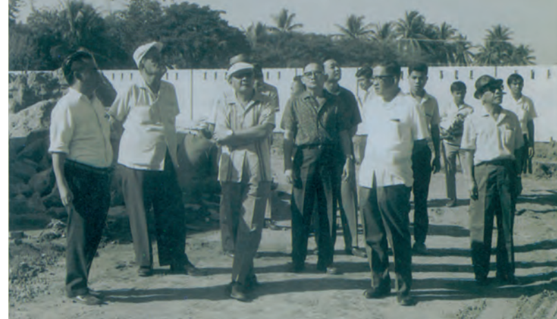
ดร.ป๋วย อึ๊งภากรณ์ ตรวจการก่อสร้างบ้านพักพนักงาน สปท. สาขาขอนแก่น
