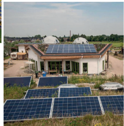
หมู่บ้าน The Aardehuizen สร้างบ้านจากขยะและวัสดุธรรมชาติ โดยออกแบบหลังคาให้อยู่ยงเพื่อรับแสงแดดได้มากในฤดูหนาว ทำให้บ้านอุ่นขึ้น ส่วนในฤดูร้อนจะลดการรับแสงแดดทำให้ อุณหภูมิในบ้านไม่สูงเกินไป พร้อมติดตั้งแผงโซลาร์เซลล์ สร้างพลังงานไฟฟ้า
