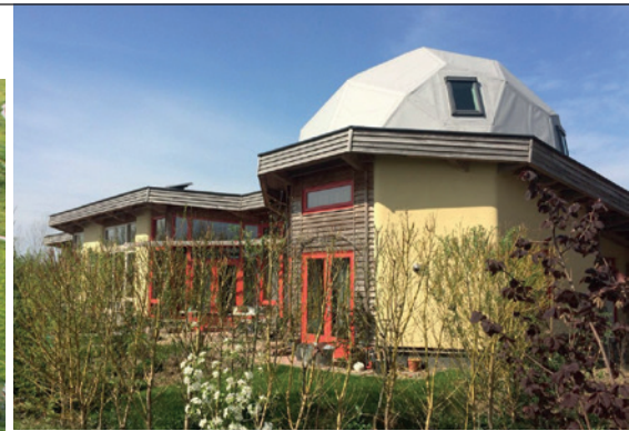
หมู่บ้าน The Aardehuizen สร้างบ้านจากขยะและวัสดุธรรมชาติ โดยออกแบบหลังคาให้อยู่ยงเพื่อรับแสงแดดได้มากในฤดูหนาว ทำให้บ้านอุ่นขึ้น ส่วนในฤดูร้อนจะลดการรับแสงแดดทำให้ อุณหภูมิในบ้านไม่สูงเกินไป พร้อมติดตั้งแผงโซลาร์เซลล์ สร้างพลังงานไฟฟ้า
