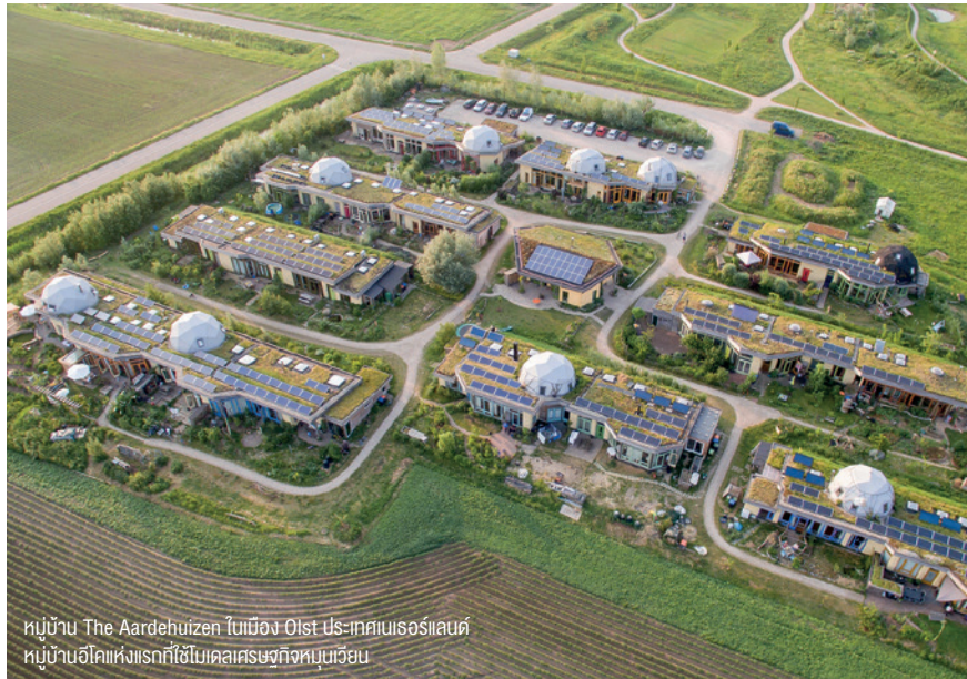
หมู่บ้าน The Aardehuizen สร้างบ้านจากขยะและวัสดุธรรมชาติ โดยออกแบบหลังคาให้อยู่ยงเพื่อรับแสงแดดได้มากในฤดูหนาว ทำให้บ้านอุ่นขึ้น ส่วนในฤดูร้อนจะลดการรับแสงแดดทำให้ อุณหภูมิในบ้านไม่สูงเกินไป พร้อมติดตั้งแผงโซลาร์เซลล์ สร้างพลังงานไฟฟ้า
