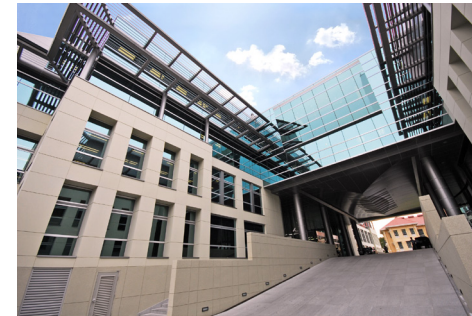
ผนังซ้อน (Double Wall) ที่มีส่วนผสมของใยแก้ว (ผนัง GRC)
