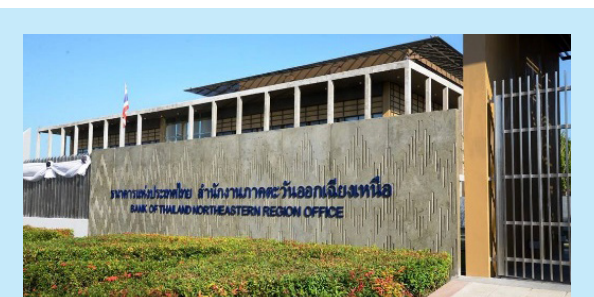
ธนาคารแห่งประเทศไทย สำนักงานภาคตะวันออกเฉียงเหนือ จังหวัดขอนแก่น ใช้แนวคิดเรื่องการประหยัดพลังงาน โดยออกแบบโถงกลางที่โล่งโปร่งเพื่อให้สามารถรับแสงสว่างธรรมชาติ กรอบอาคารมีแผงบังแดดช่วยลดทอนความร้อนจากแสงภายนอก รวมถึงติดตั้งเซลล์แสงอาทิตย์เพื่อนำพลังงานแสงอาทิตย์มาใช้กับเสาไฟแสงสว่างในบริเวณรอบอาคารด้วย
