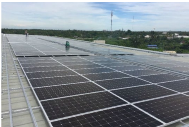
การติดตั้งระบบโซลาร์เซลล์ บนหลังคาอาคารผลิตธนบัตร
